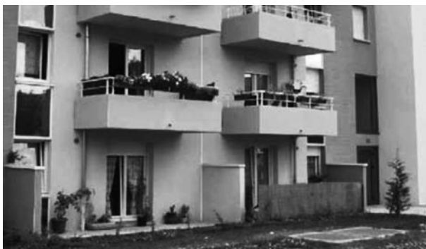
▲ Photo 12.1. Exemple de rez-de-chaussée offrant peu d'intimité Ce défaut est confirmé par l'installation, pour l'appartement de droite, de panneaux d'occultation peu esthétiques. En outre, la terrasse de plain-pied est trop petite.
