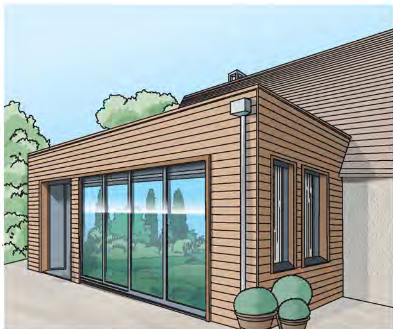
Extension à toit plat en ossature bois
