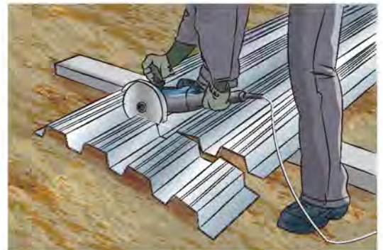
e Découpage des tôles nervurées
