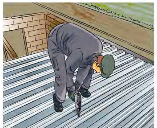
f Fixation des tôles nervurées en acier
